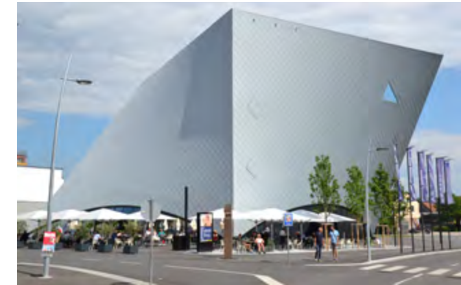
Landesgalerie Niederösterreich, 3500 Krems Marte.Marte Architekten ZT GMBH Foto: Total Solution
