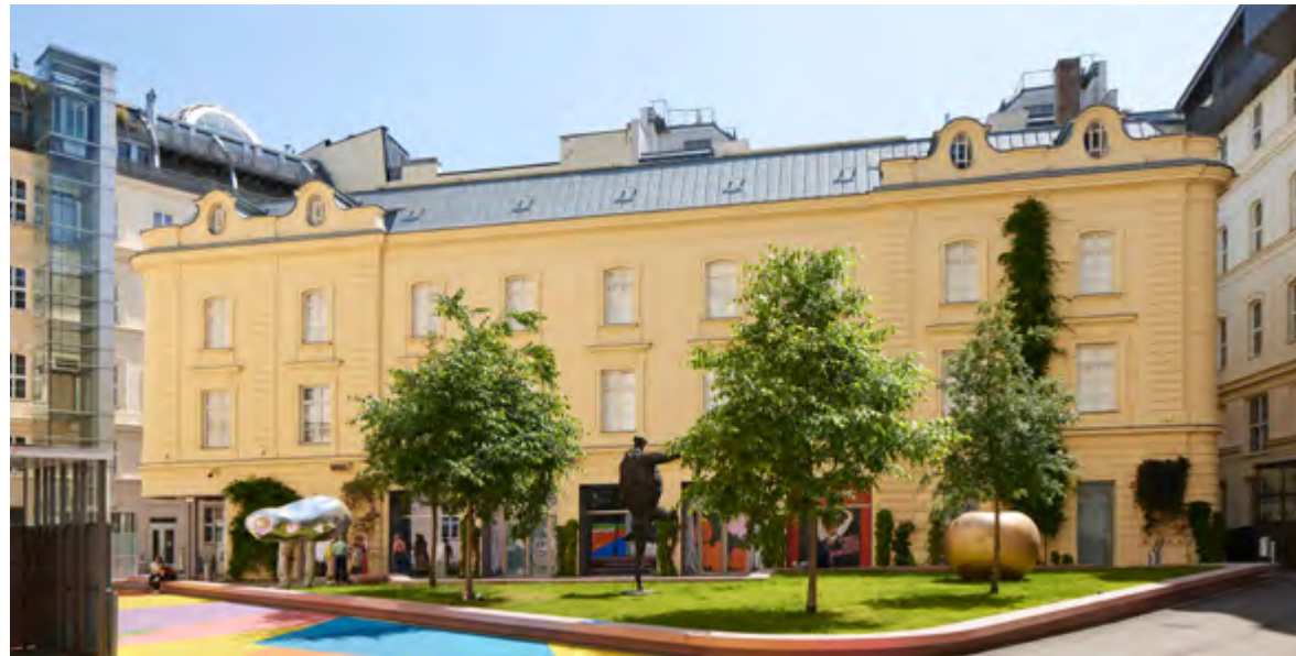
Horten Collection, 1010 Wien tnE Architects ZT GmbH Foto: Walter Oberbramberger
