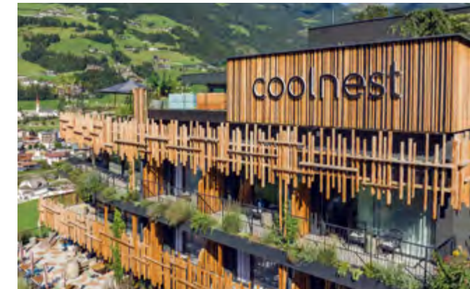
coolnest Designhotel, 6284 Ramsau im Zillertal Hotel & Spa Archifaktur GmbH Foto: Tom Klocker
