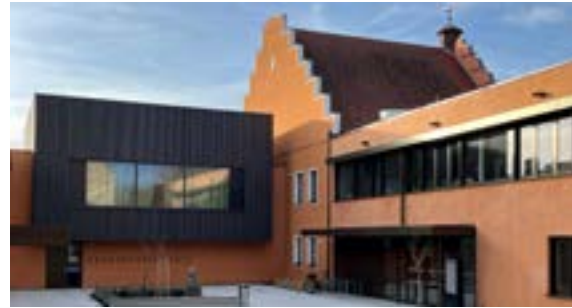
Rathaus und Museum, 3435 Zwentendorf maul - architekten zt gmbh Foto: Total Solution
